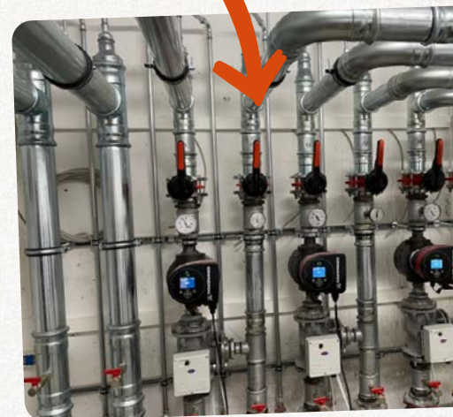
... und neues Zweirohrheizsystem im Gerüstbauerring
