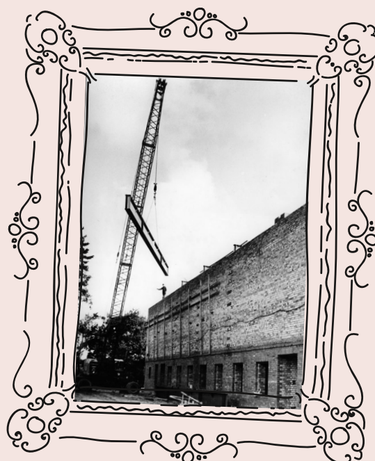
Bau der Kunsthalle Rostock, 1968 , Foto: Kunsthalle Rostock
